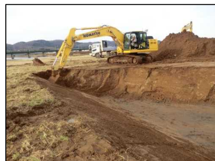
ICTバックホウの施工状況 (掘削法面整形)
