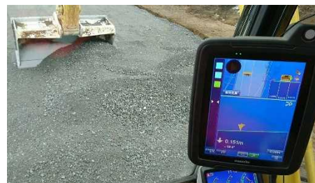
MCバックホウによる路盤材敷均し(応用活用)
