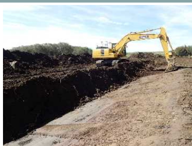
MCバックホウによる 掘削状況
