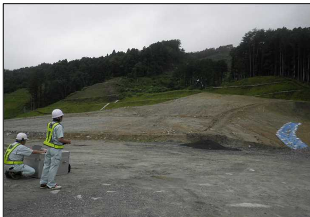
UAVによる施工前の空中写真測量
