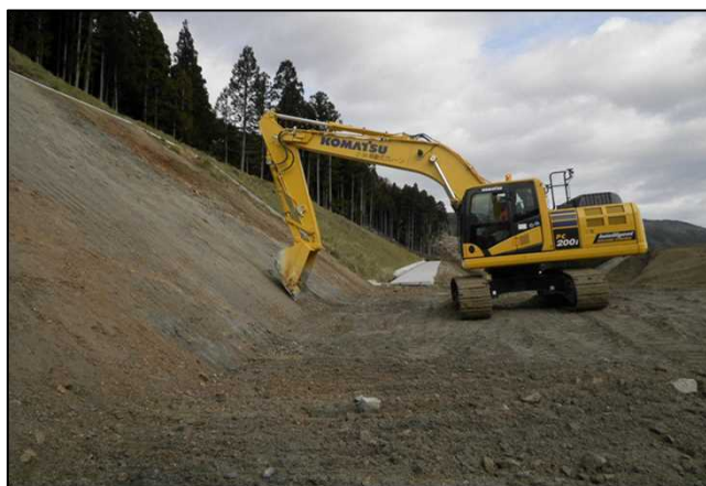
ICTバックホウによる法面整形
