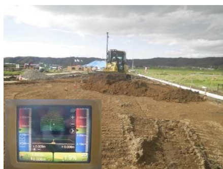
MCブルドーザによる敷均し
