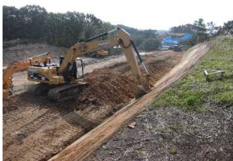
MGバックホーによる 切土法面整形
