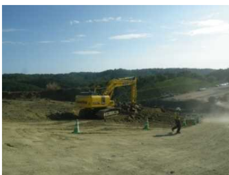
ICT建機による隣接工区との境界線確認と掘削状況
