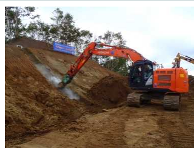
ICT建機による排水掘削実施
