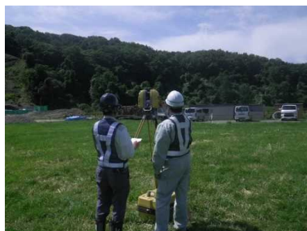
LS(レーザースキャナ)による起工測量
