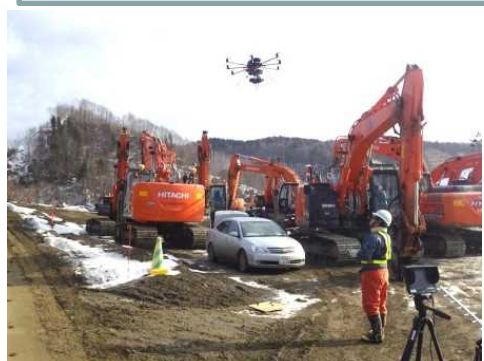
UAVを用いた空中写真測量 (上空視界良好範囲)
