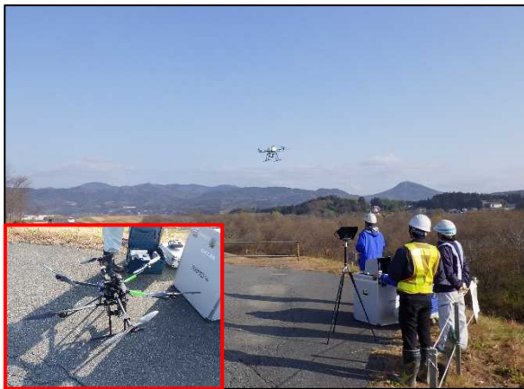
UAVによる施工前の空中写真測量
