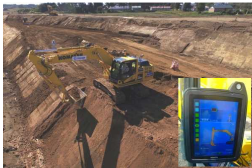
MCバックホーによる 盛土法面整形
