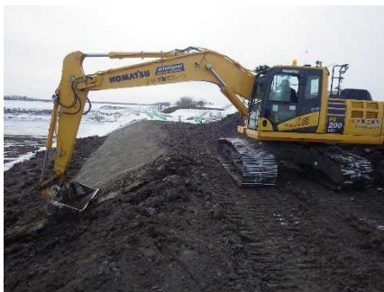
MCバックホーによる切土整形
