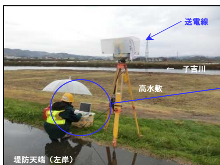
LS(レーザースキャナー)による 施工前測量状況
