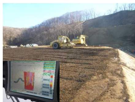
GNSS転圧管理システム 搭載振動ローラによる転圧
