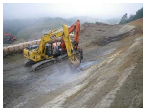
ICT建機による切土法面整形
