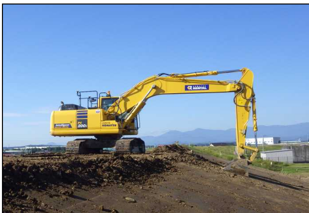
ICTバックホウによる法面整形
